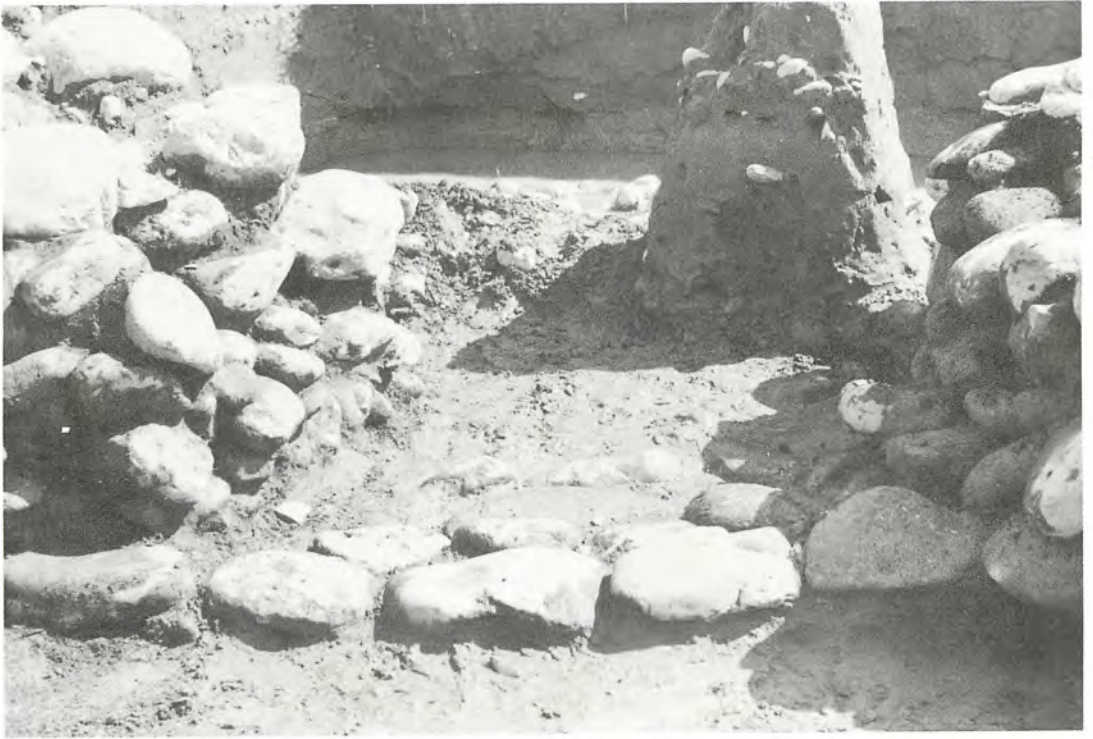
(1) 堤防基礎部構築状況
