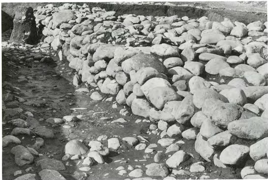
(2) 堤防構築状況 (外側)
