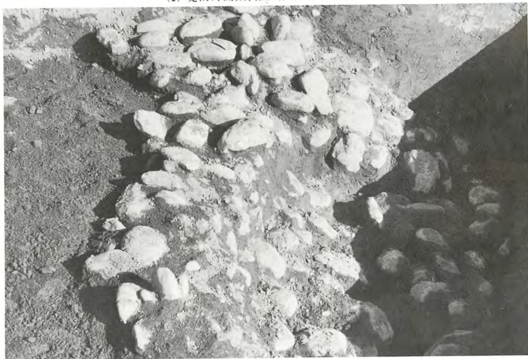
(2) 堤防構築状況 (西方より望む)
