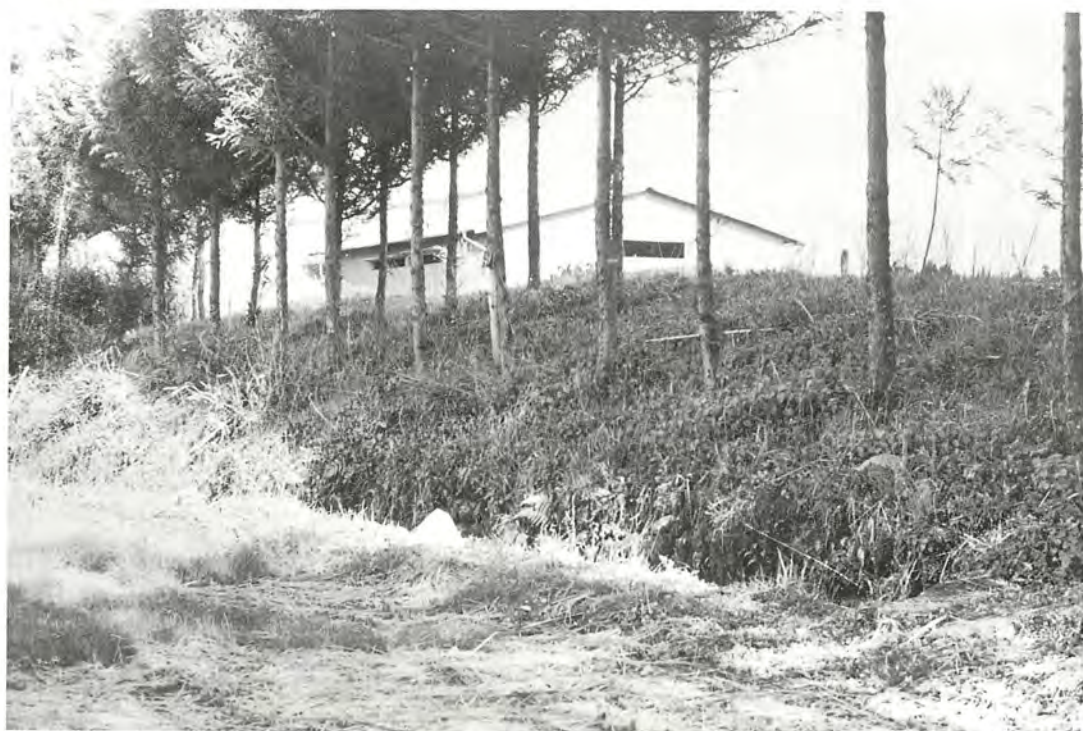
(1) 北方より北側土塁を望む
